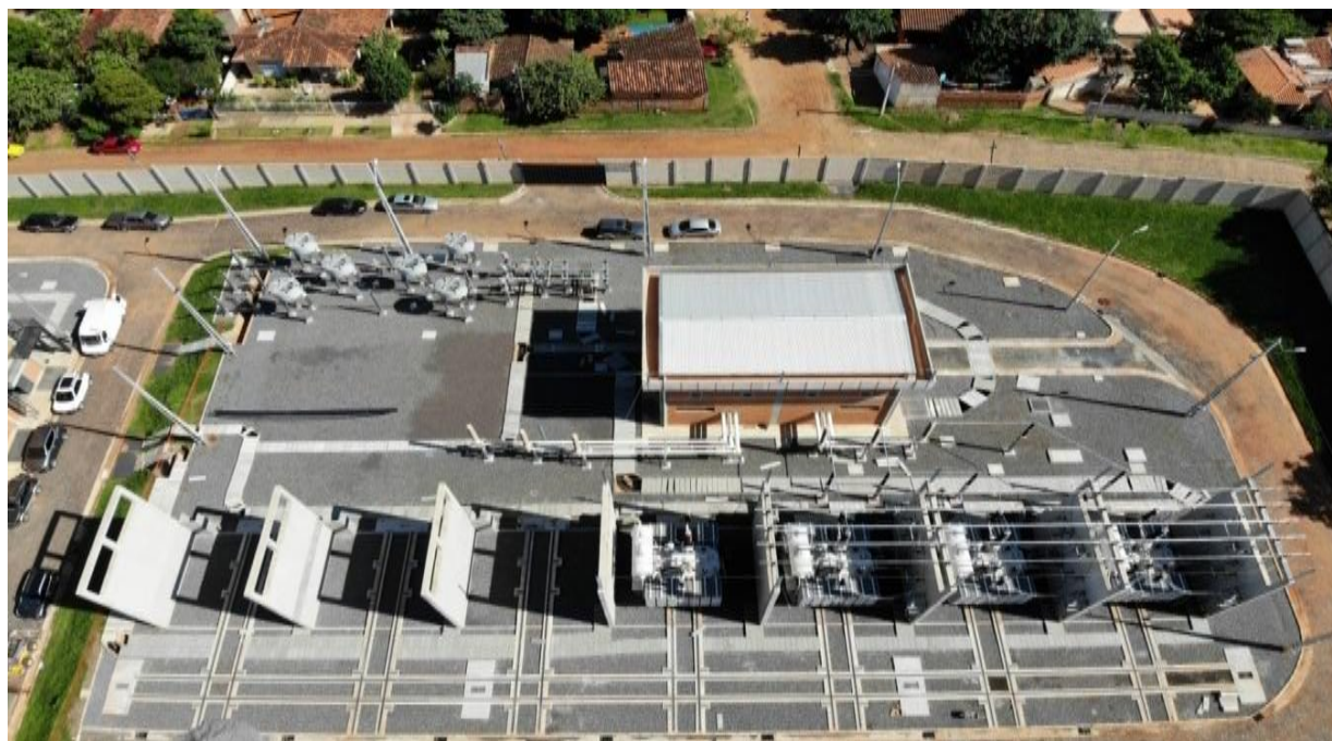
Construcción de la Subestación Barrio Molino en 220/66/23 - Licitación Pública Nacional ANDE N° 1090/2014 - Lote 1 - BONOS II
